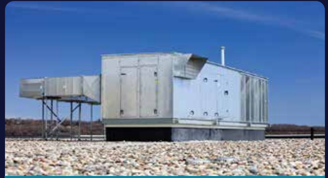
وحدة مناولة الهواء / وحدة مناولة الهواء النقي
